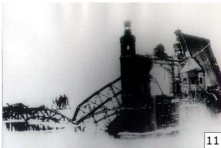
Мост после взрыва 1944 год.
