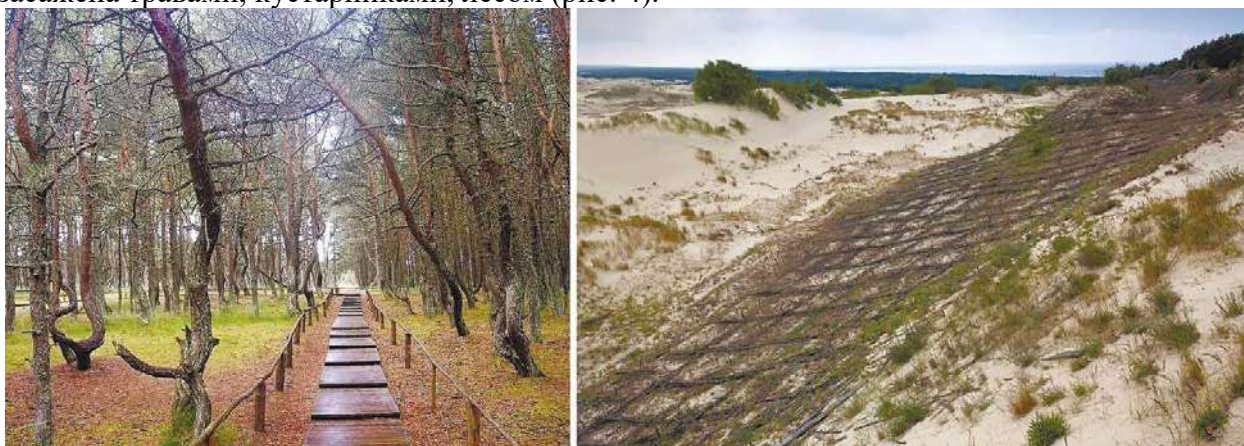
Рис. 4. Защита почвенного слоя и закрепление песков.
